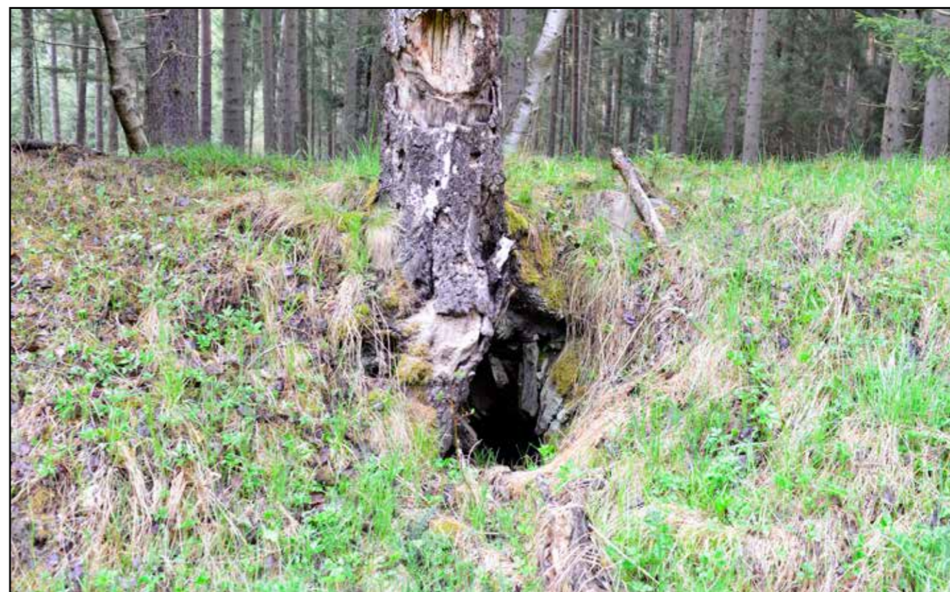
Klenutý propustek, strana k trati, 2022.
