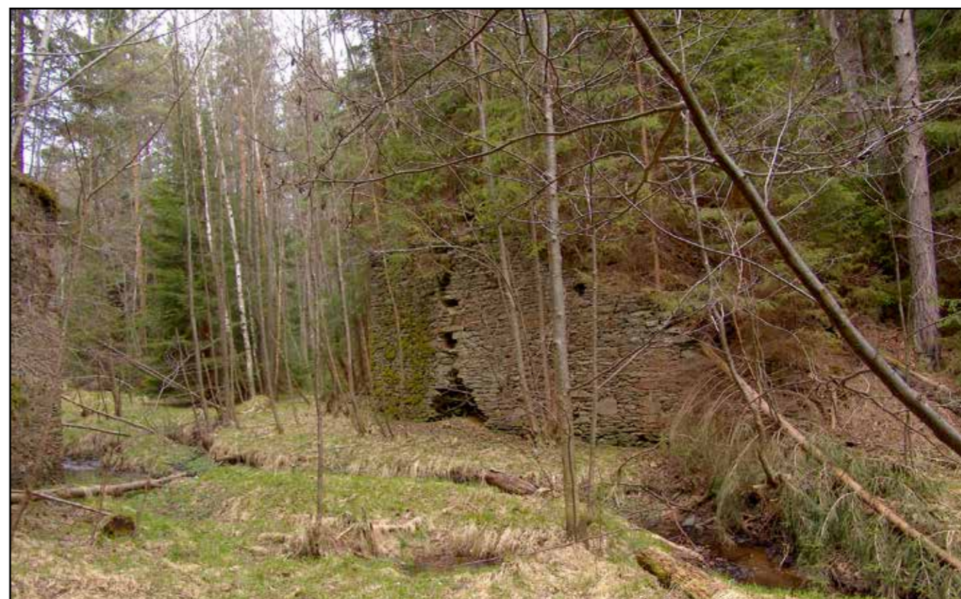
Pilíře druhého dřevěného mostu, pohled od východu, 2007.
