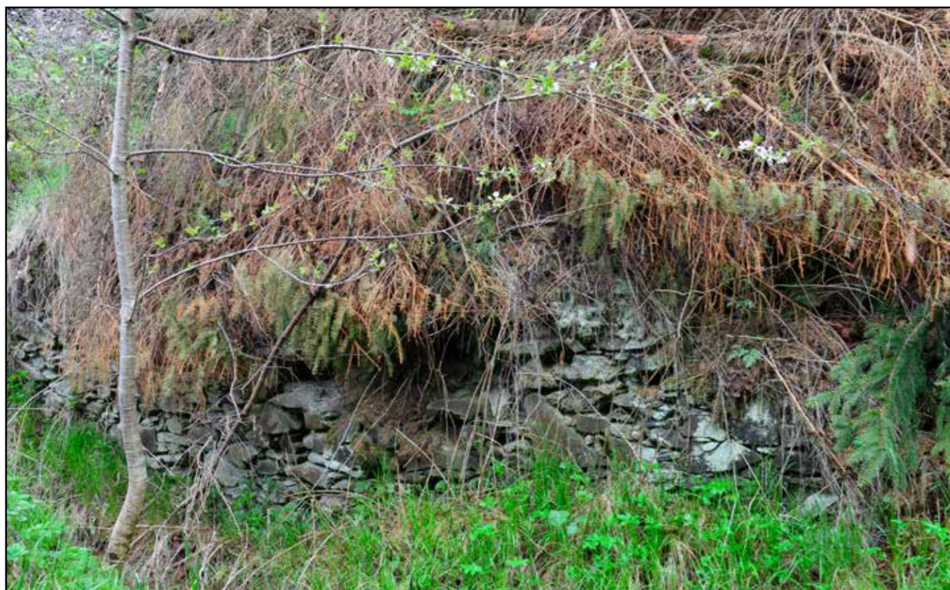
Detail severního pilíře, 2022.
