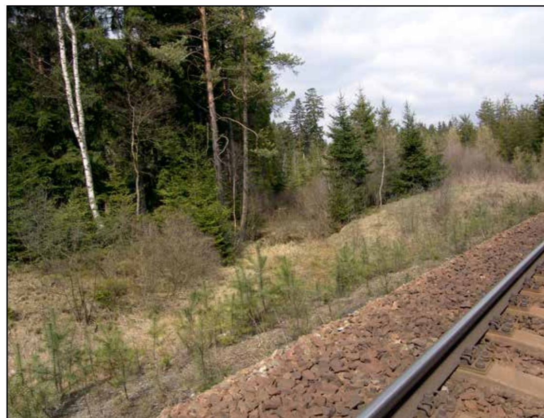
Ústí zářezu u stávající železniční trati na km 72.125, 2007.
