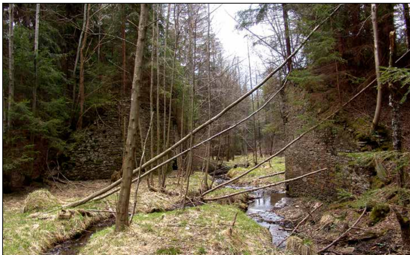
Pilíře druhého dřevěného mostu, pohled od západu, 2007.
