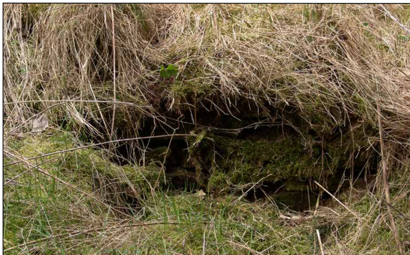
Rozvaliny bývalého strážního domku nedaleko Dolního Dvořiště na km 71.9, 2007.
