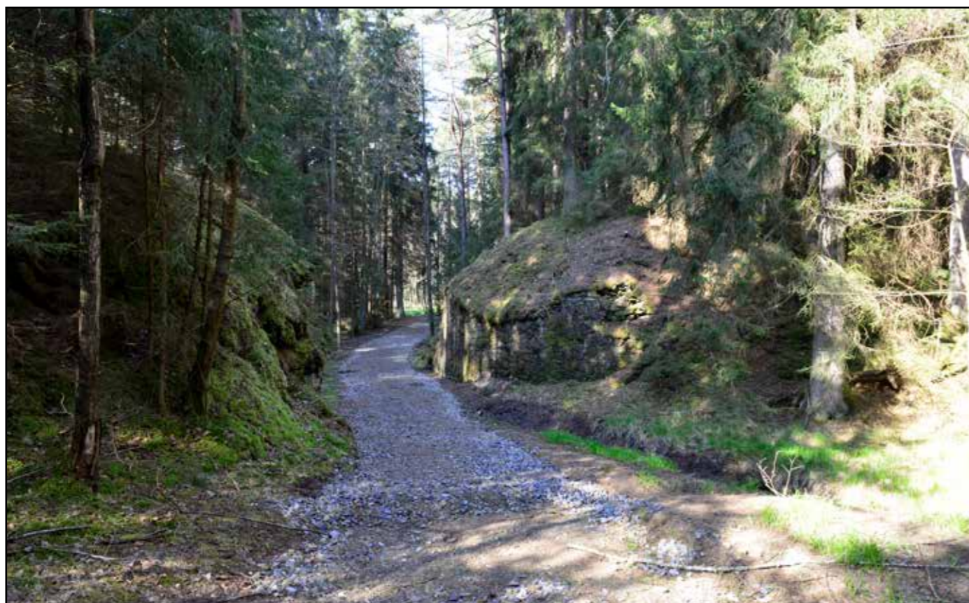
Pilíře dřevěného mostu, pohled od jihu, 2022.
