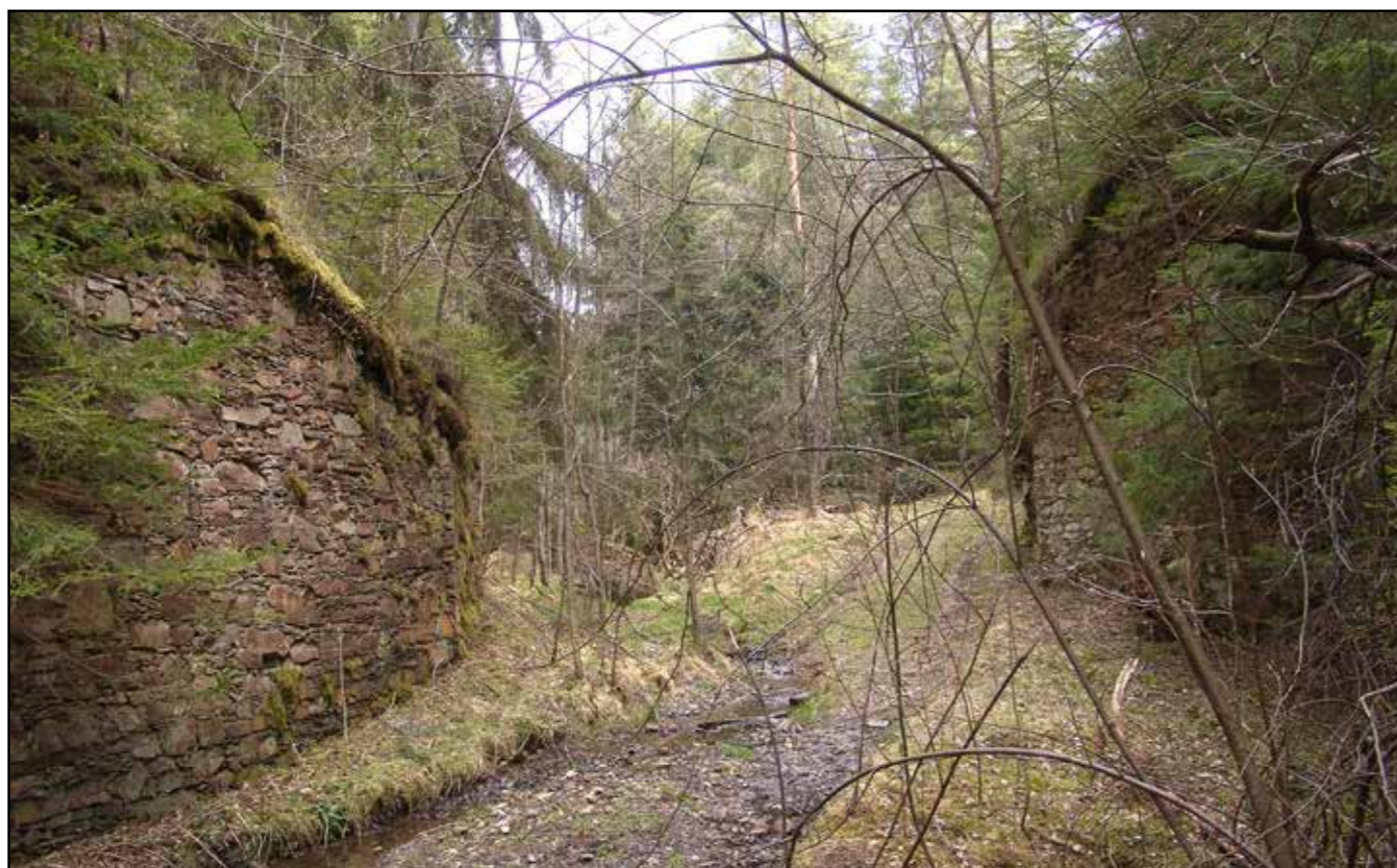
Pilíře dřevěného mostu, pohled od jihu, 2007.
