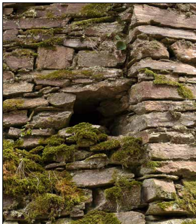
Detail otvoru po dřevěné konstrukci mostu, 2007.
