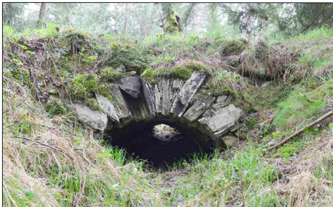
Klenutý propustek, 2022.
