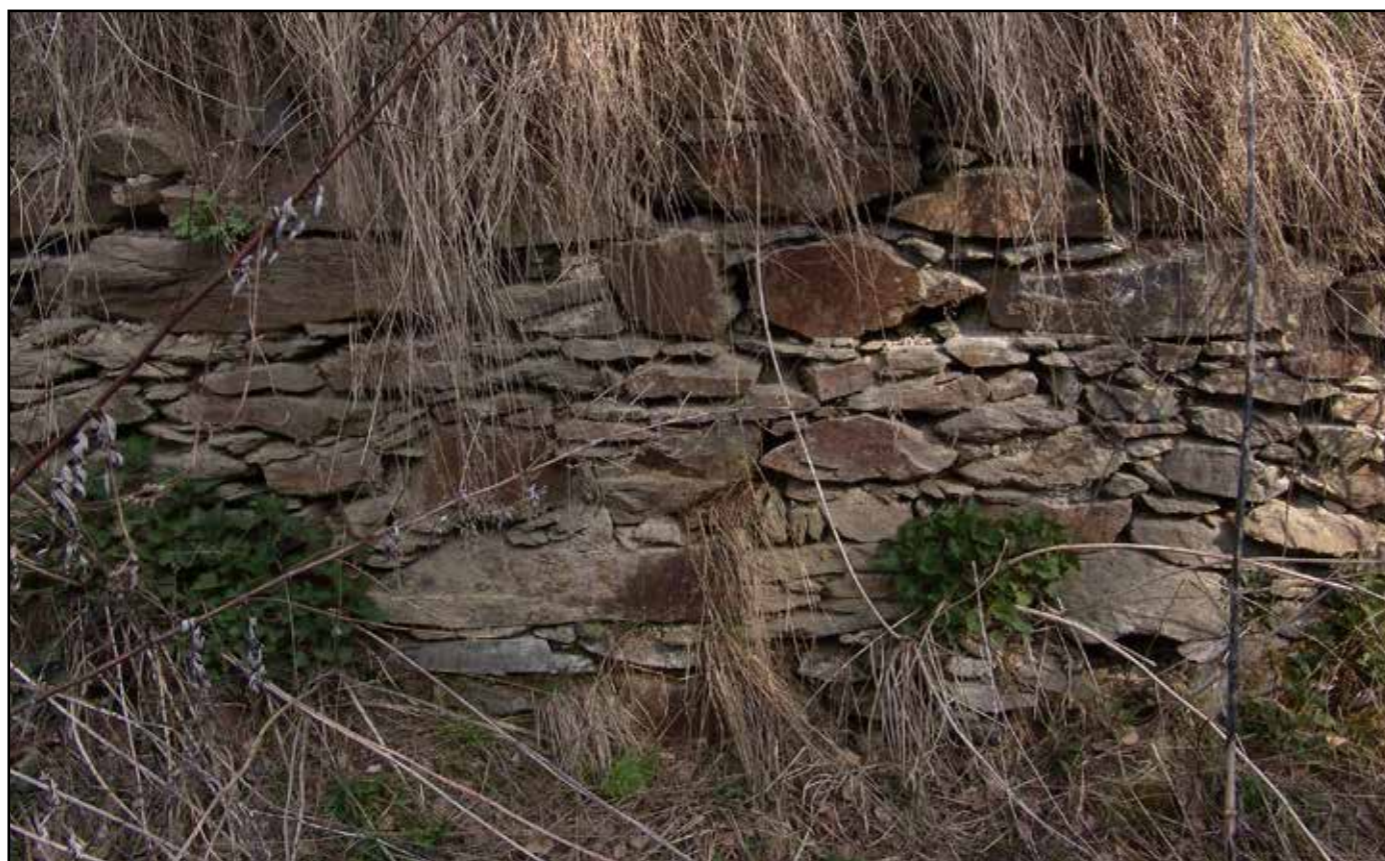
Detail severního pilíře.
