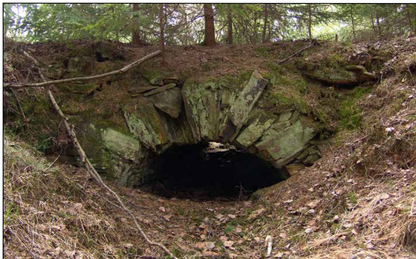
Klenutý propustek, 2007.
