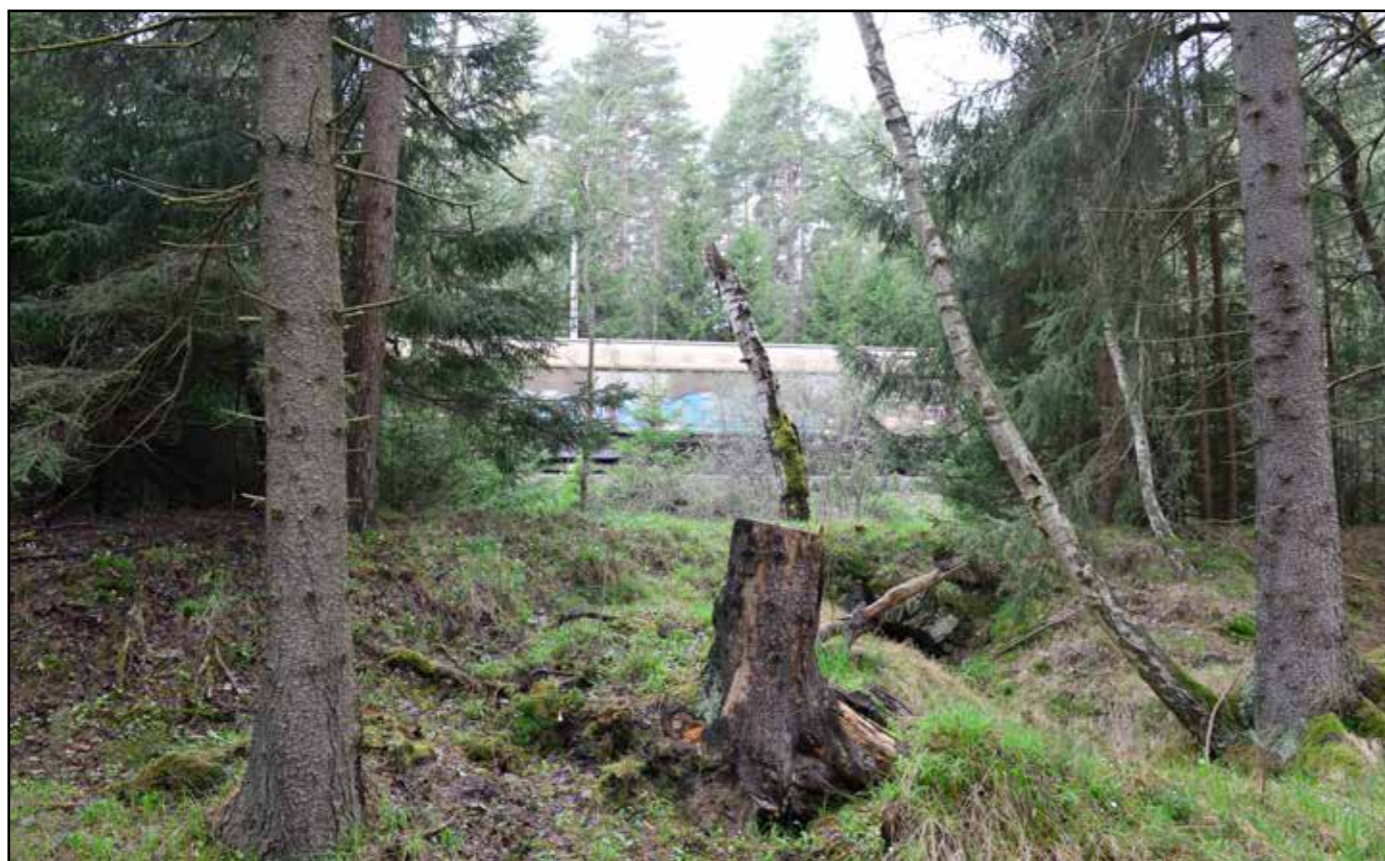
Celkový pohled od západu na propustek v náspu, 2022.
