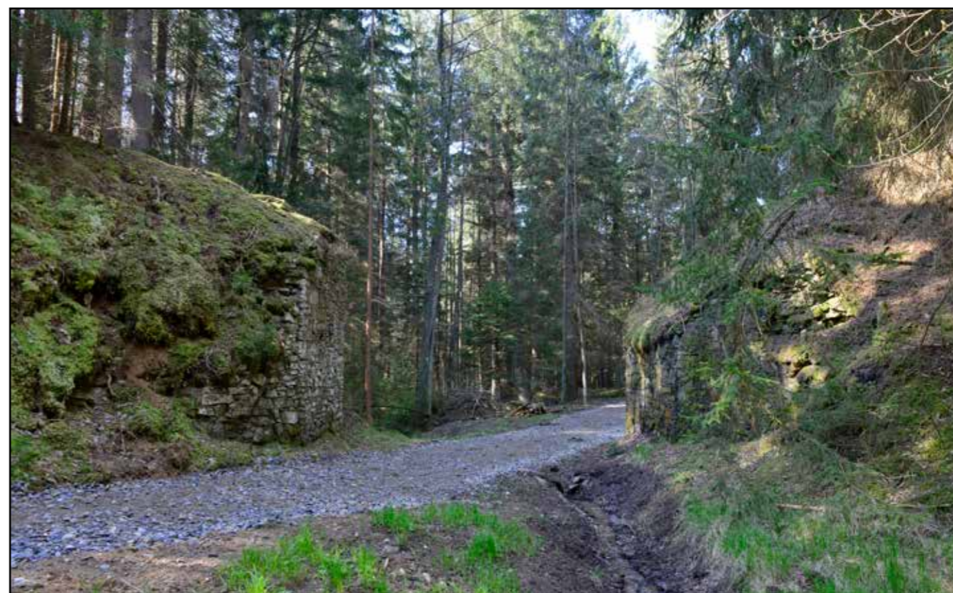
Pilíře dřevěného mostu, pohled od severu, 2022.
