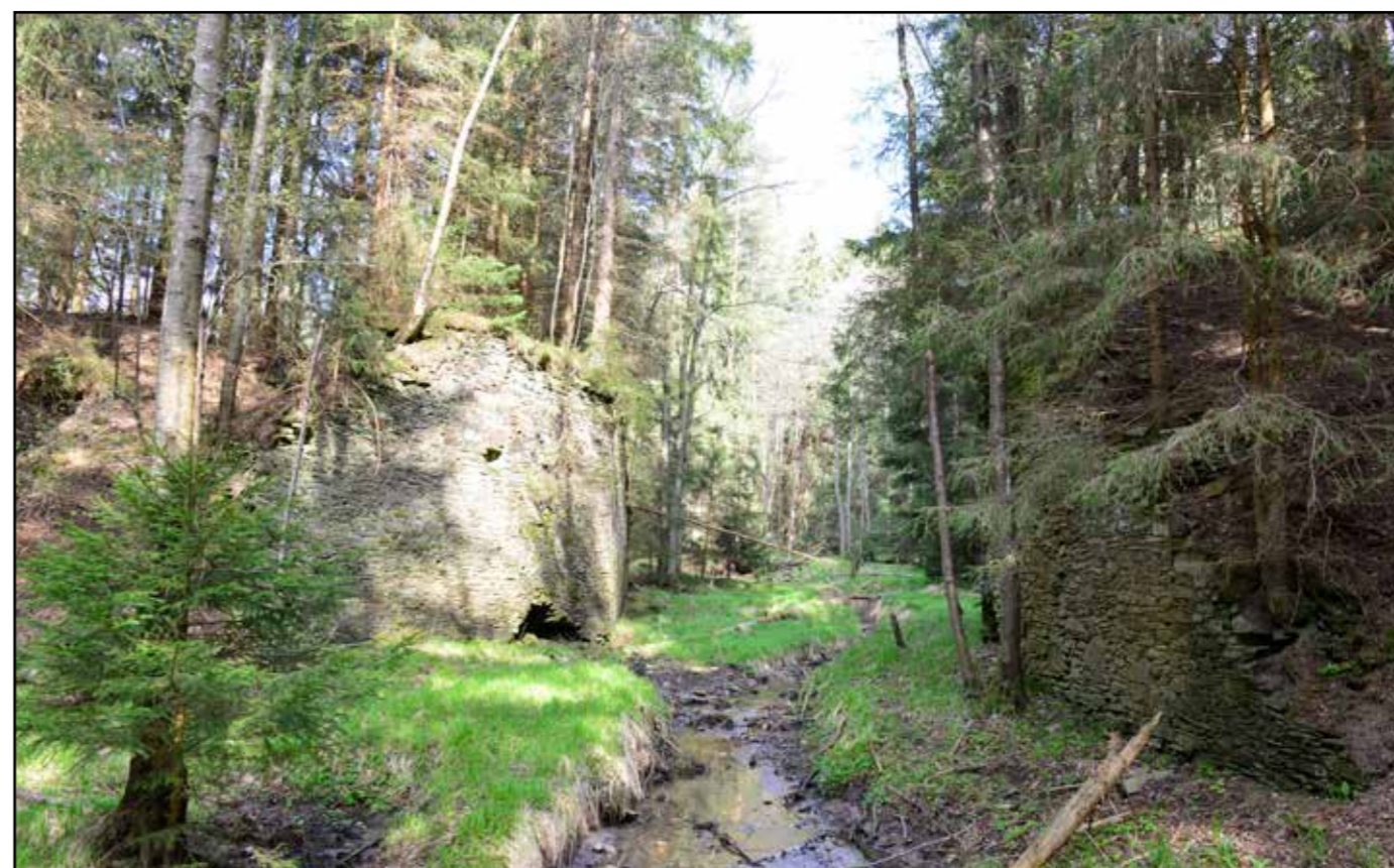
Pilíře druhého dřevěného mostu, pohled od východu, 2022.
